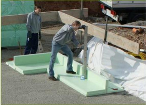
Das Iso-Therm-Bodenplattensystem ist ein Schalungssystem zum Erstellen wärmedämmter Gründungsplatten.
