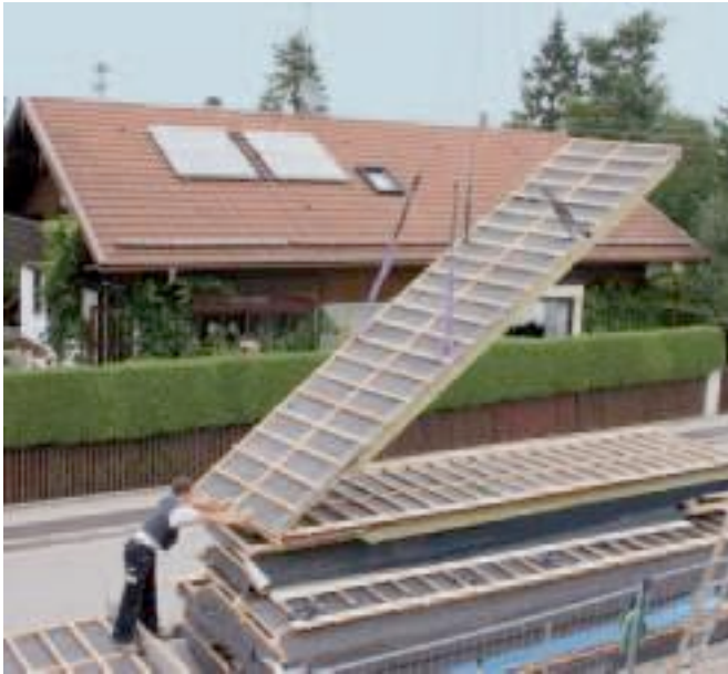
Termingerechte Lieferung an die Baustelle.
