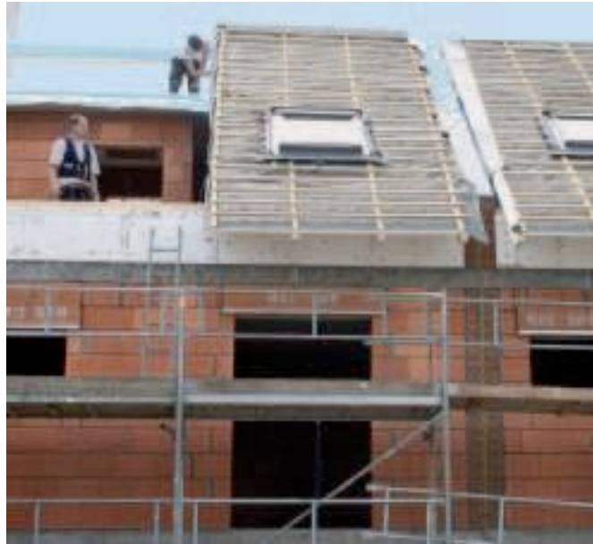
Zügige Verankerung, da Verbindungsmittel im Bauteil integriert sind.
